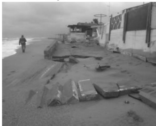
Σχήμα 6: Χαρακτηριστική περίπτωση κατεστραμμένης περιφραξής κατοικίας από το χειμérico κύμα σε περιοχή μεταξύ των τομών 8 και 9.
