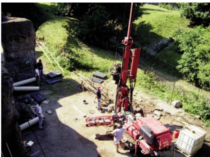
Penetrazione della sonda nel Lupercale
