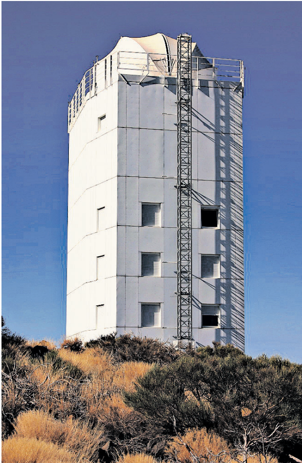
Το ηλιακό τηλεσκόπιο GREGOR βρίσκεται «κρυμμένο» στην κορυφή του κτηρίου
