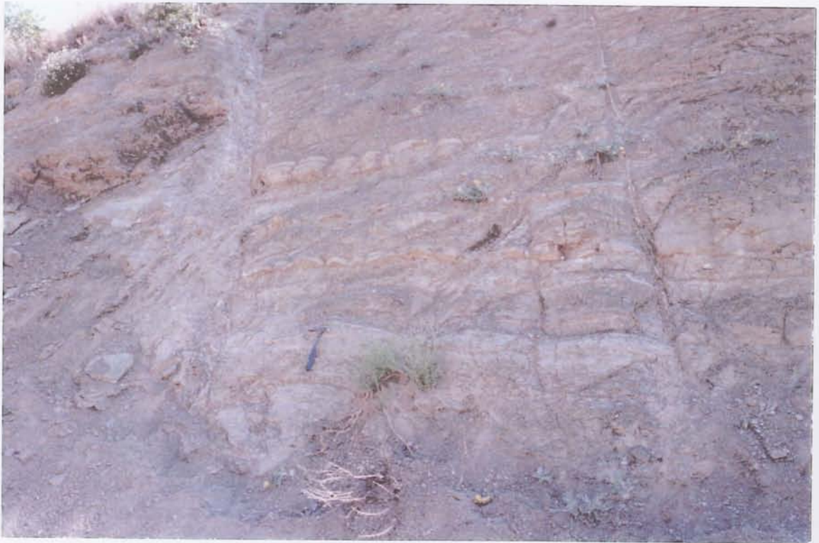
Εικ. 5-11. Ρήγμα στους μολασσικούς σχηματισμούς.
