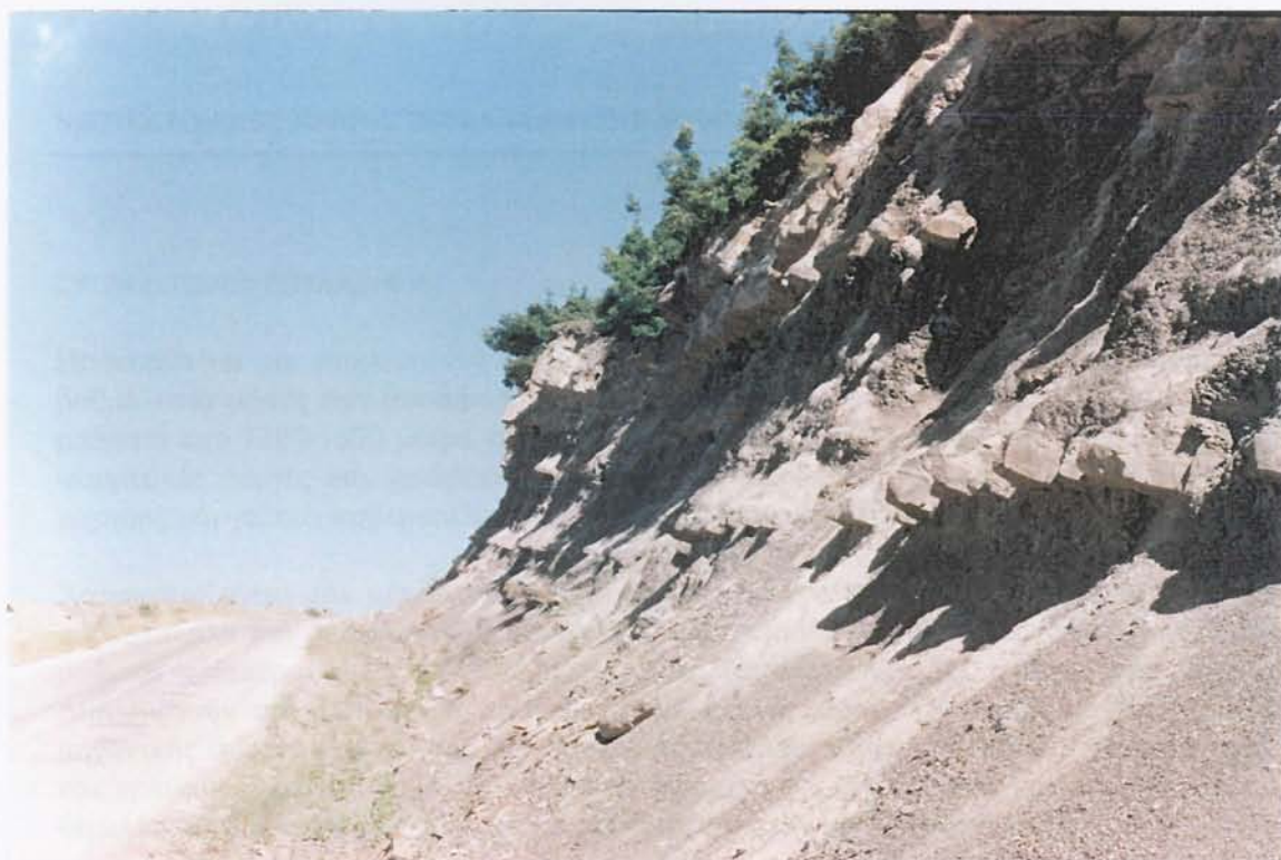
Εικ. 4-1. Φαινόμενα καταπτώσεων λόγω διαφορεικής διάβρωσης στον σχηματισμό Πενταλόφου σε θέση που απέχει ένα περίπου χιλιόμετρο από την κοινότητα Οροπεδίου του νομού Γρεβενών.
