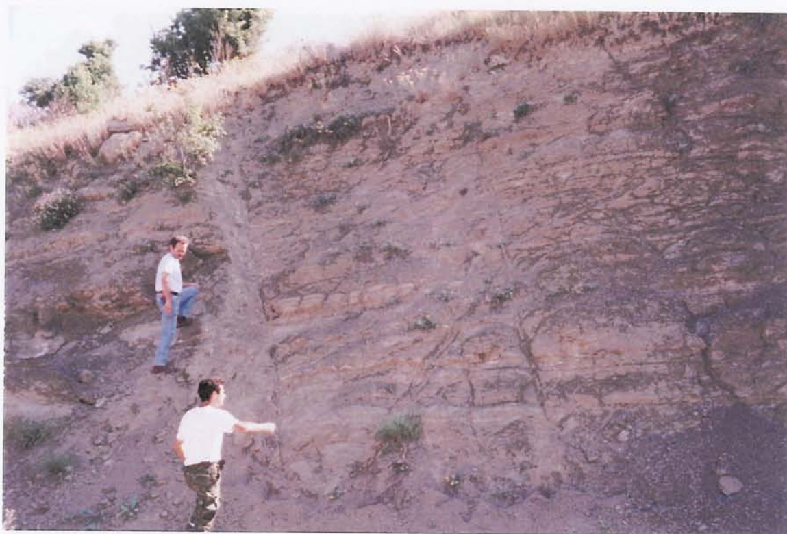
Εικ. 5-14. Ρήγμα στους μολασσικούς σχηματισμούς.
