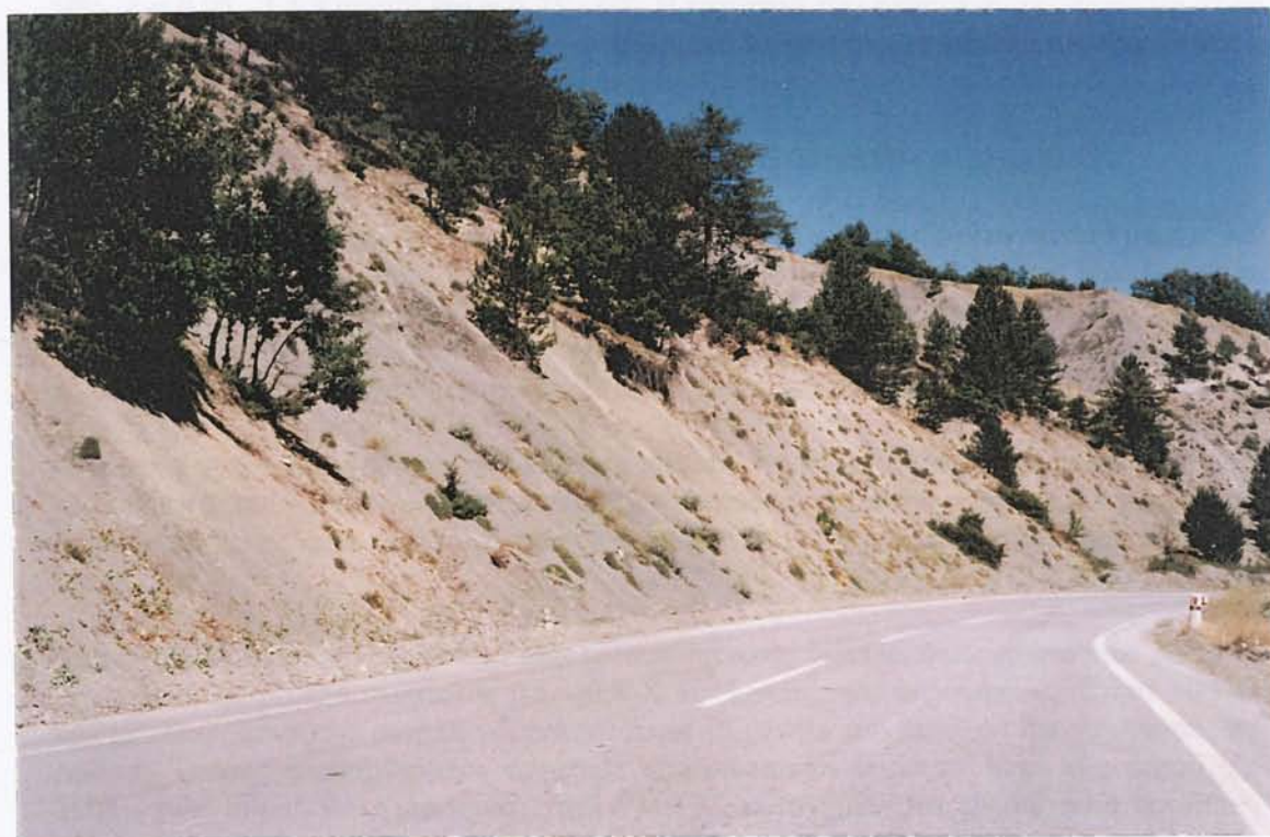
Εικ. 4-2. Τεφρές μάργες του σχηματισμού Επταχωρίου, ένα χιλιόμετρο μετά την ομώνυμη κοινότητα. Λόγω της εύκολης αποσάθρωσης είναι επιρρεπείς σε φαινόμενα κατολισθήσεων και εδαφικών ρωών.
