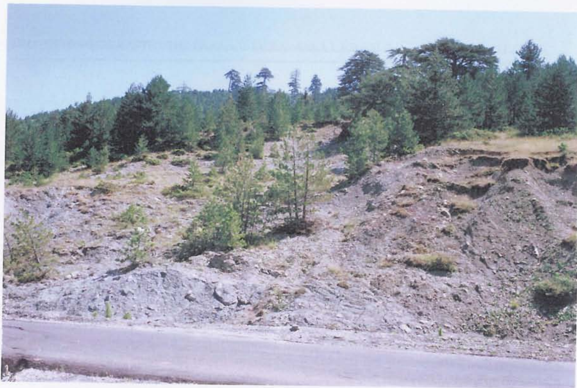
Εικ. 4-3. Τα κυριότερα χαρακτηριστικά μίας κατολίσθησης.
