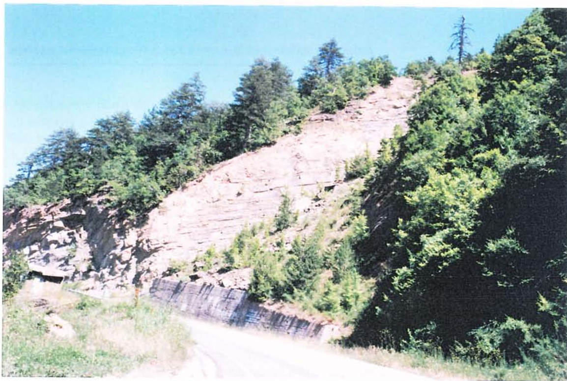
Εικ. 4-7. Τοίχος αντιστήριξης και συγκράτησης για προστασία του κεντρικού οδικού άξονα Πενταλόφου-Επταχώρι. Στη φωτογραφία διακρίνεται ότι τα κατολίσθοντα υλικά έχουν ξεπεράσει το ύψος του τοίχου.
