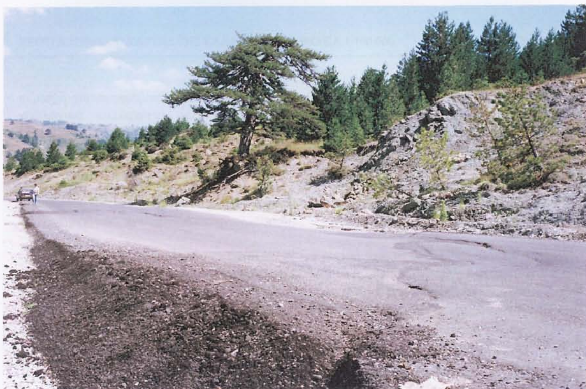
Εικ. 4-5. Ρωγμές και καθιζήσεις στον νεοασφαλτωμένο οδικό άξονα Αρδέλας-Σμίξης μετά τη διασταύρωση προς Πανόραμα, που προκλήθηκαν από τυπικές περιστροφικές κατολισθήσεις του φλύσχη.
