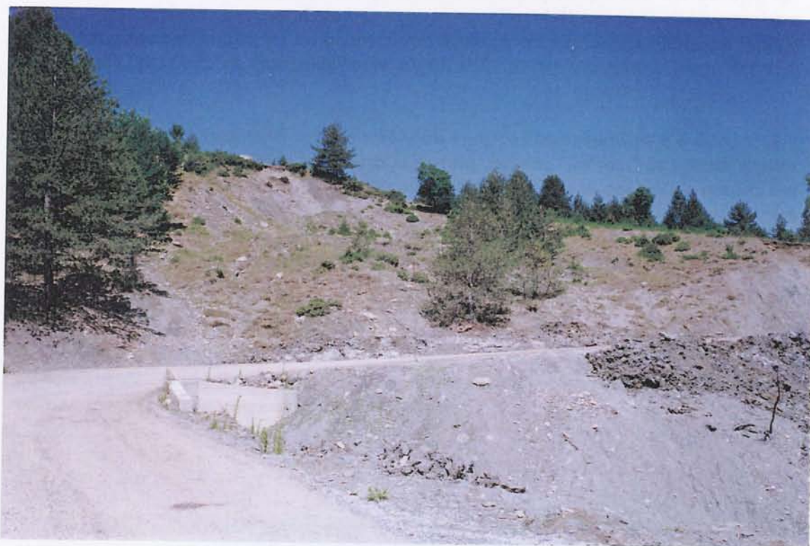
Εικ. 4-4. Στη φωτογραφία διακρίνεται η κατολίσθηση που προκάλεσε την καταστροφή του επαρχιακού δρόμου Αβδέλας-Σμίκης, ενώ φαίνεται και η κορυφή της κατολίσθησης. Διακρίνεται η νέα διάνοιξη του δρόμου που ακολουθεί την παλιά και η οποία έχει πραγματοποιηθεί διαμέσου των κατολισθέντων υλικών.
