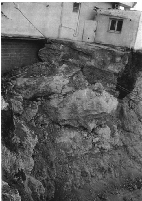
Εικ. 1 Υποχώρηση βραχωδών τεμαχίων που προήλθαν από τη δράση ρηξιγενούς ζώνης στην πόλη της Ρόδου.
