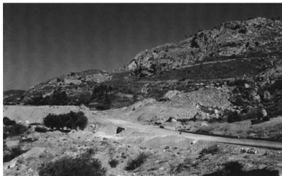
Εικ. 2 Εκδήλωση κατολισθήσεων κατά μήκος ρηξιγενούς ζώνης στην οδό Πλατανιά – Απόλλωνα Ρόδου.
