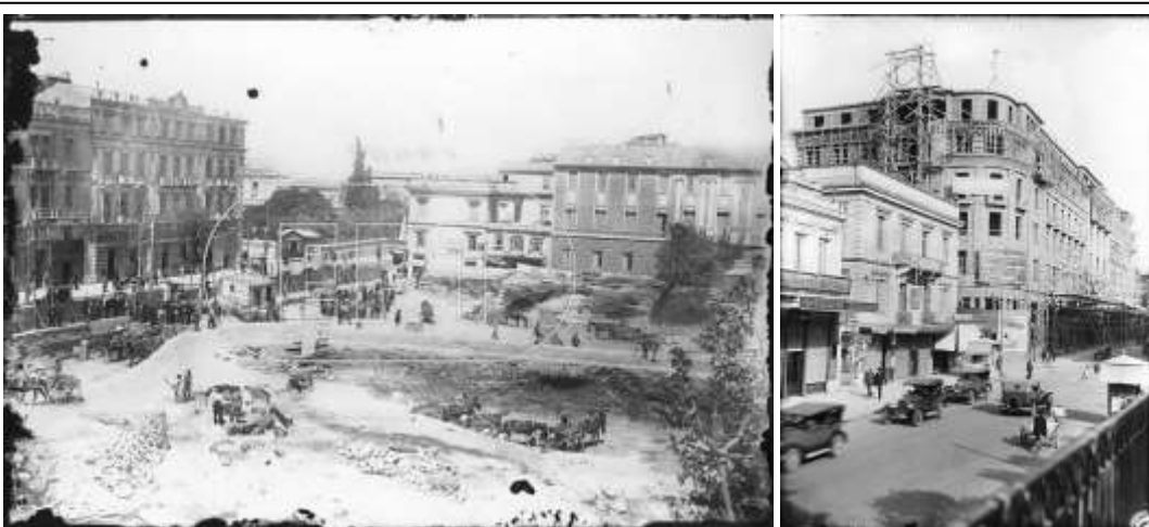
Οι εργασίες θεμελίωσης για την ανέγερση του μεγάρου του μετοχικού ταμείου στρατού στη θέση των βασιλικών σταύλων (1927) και άποψη του μεγάρου σε προχωρημένη φάση ανέγερσης (1930-39).
