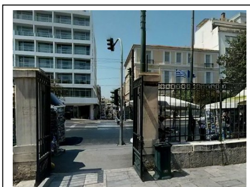
Αναπαλαιωμένο κτίριο απέναντι από είσοδο του Εθνικού κήπου επί της λεωφόρου Αμαλίας.
