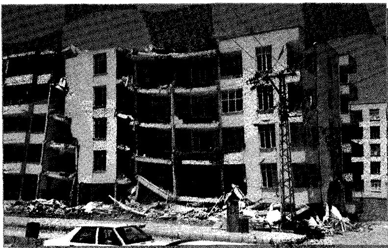
Εικ. 2. Άποψη μίας από τις πολυκατοικίες που κατέρρευσαν στην πόλη Σεγχαί. Η κατάρρευση οφείλεται μεταξύ των άλλων στον επιμήκη προσανατολισμό της, στην ποιότητα κατασκευής και υλικών και στα φαινόμενα κατευθυντικότητας της σεισμικής ενέργειας
