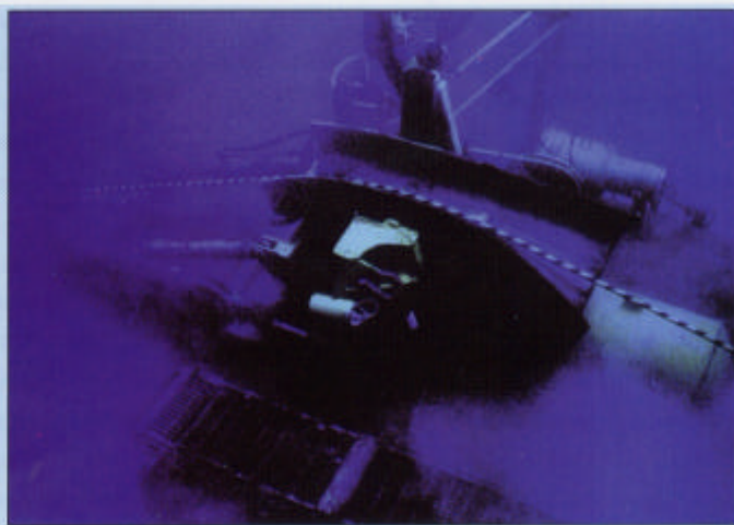
Εικ. 3. Το υποβρύχιο «άροτρο» ενώ θάβει το ηλεκτρο-οπτικό καλώδιο στον κόλπο της Μεθώνης.
