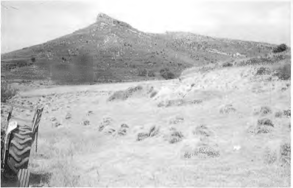
Εικ. 39. Επιφάνεια αποκόλλησης των ασβεστολίθων του Σχηματισμού Ρεθύμνου. Η τεκτονική μετακίνηση έλαβε χώρα προς βορράν.
